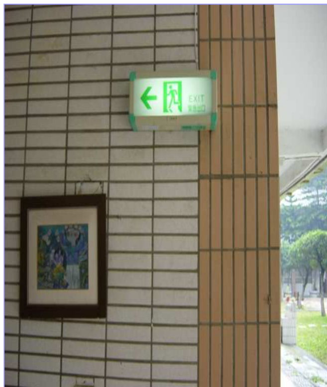
設置消防安全設備
