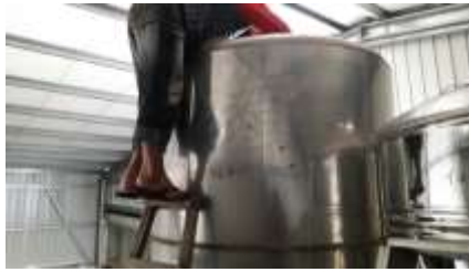
定期清洗水塔
